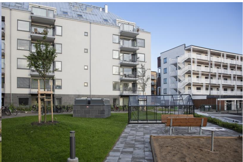
Byggnation på Fallskärmen 1 och 2
