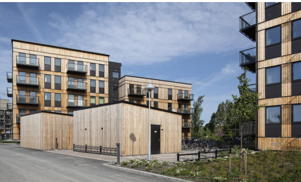
Byggnation på fastigheten Glidplanet 5
